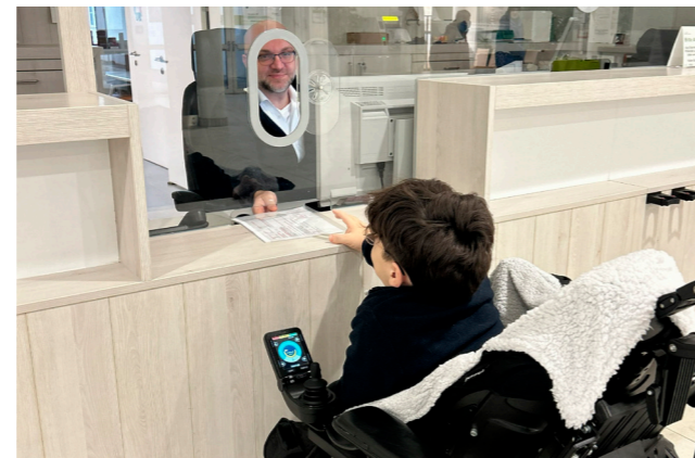
Im Haupteingang wurde der Bereich beim Portier sowie bei den Ambulanzen barrierefrei umgebaut. Ein Bereich wurde sowohl in der Portierloge als auch bei der Anmeldung zu den Ambulanzen baulich tiefer gelegt, um es Rollstuhlfahrer*innen zu ermöglichen, auf Augenhöhe mit Mitarbeiter*innen zu kommunizieren und Unterlagen einfacher übergeben zu können.
